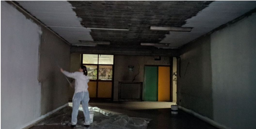
Figura 23 - Lavori di tinteggiatura
