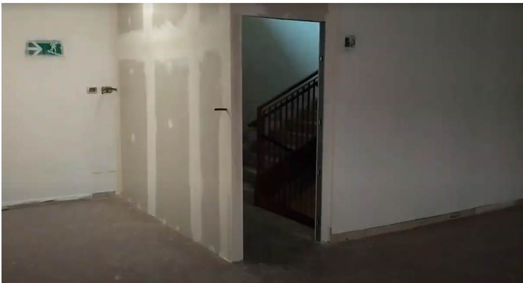
Figura 25 - Lavori di muratura
