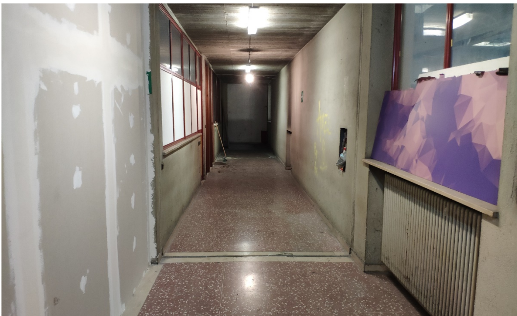
Figura 26 - Lavori di muratura
