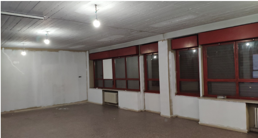
Figura 24 - Lavori di tinteggiatura
